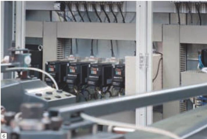
Bild 6: MX2-Umrichter regeln sämtliche Antriebe der Transport- und Rollenbänder. Durch die freie Programmierbarkeit können die Umrichter kleine SPS-Funktionen ausführen und als Stand-alone-Lösung zum Beispiel eigenständig Positionieraufgaben übernehmen, ohne die Maschinensteuerung zu belasten. (Foto: Omron)
